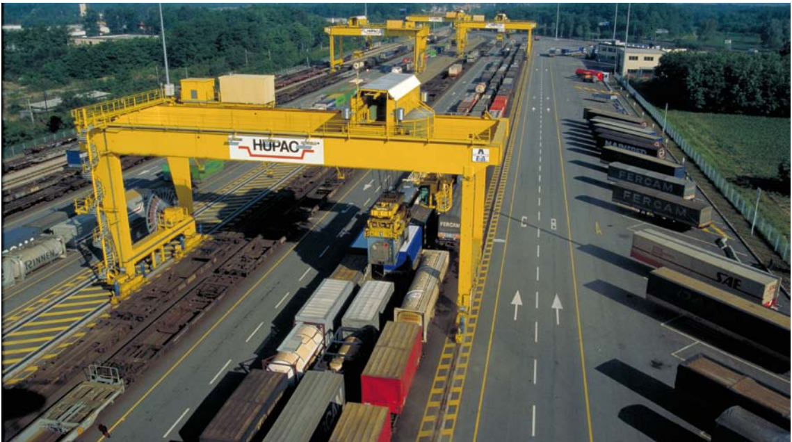
Rechts im Bild: Sattelanhänger stehen bereit für die Verladung in den Kombi-Zug
